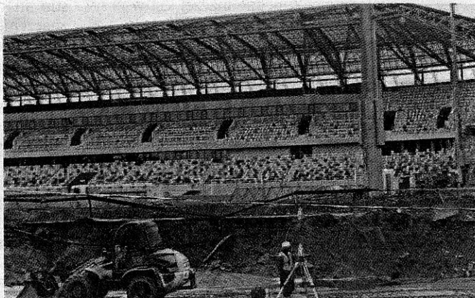
► 3 TYS. TON NAD GŁOWAMI: Promostal wykona i zmontuje zadanie drugiej części stadionu w Białymstoku (obecnie powstało ok. 40 proc. obiektu). [FOT. ARC]
