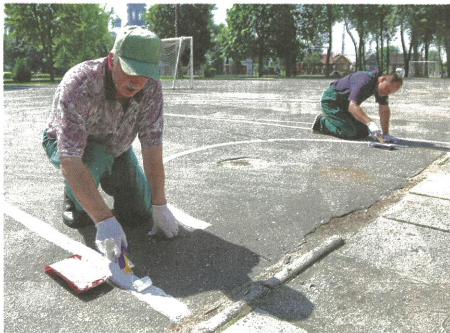
▶ Trwają wakacyjne prace w gimnazjum w Wasilkowie. Wczoraj robotnicy namalowali na szkolnym boisku pasy. Ekipy remontowe wkroczyły też do innych szkół w podbiałostockich gminach.
